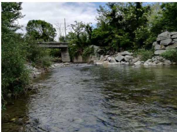
Punto di ripresa n° 4 – particolare scogliera oggetto di rifacimento
