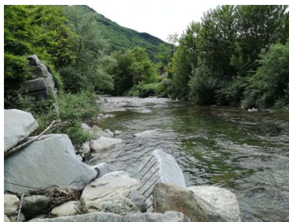
Punto di ripresa n° 6 – particolare scogliera oggetto di rifacimento
