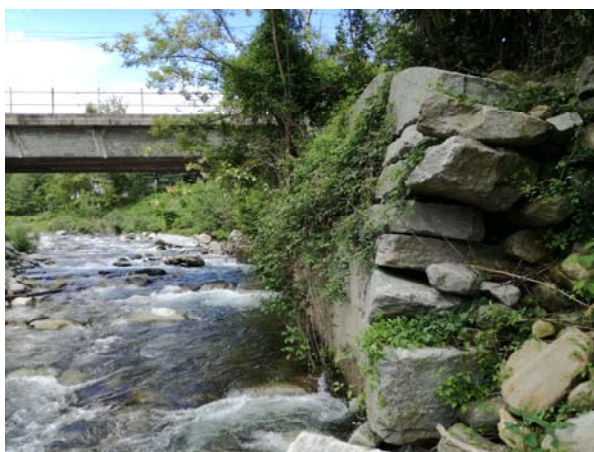
Punto di ripresa n° 5 – particolare scogliera oggetto di rifacimento
