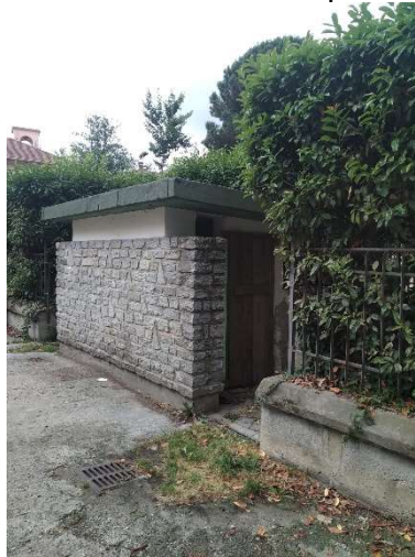
Figura 10. I servizi igienici oggetto di demolizione
